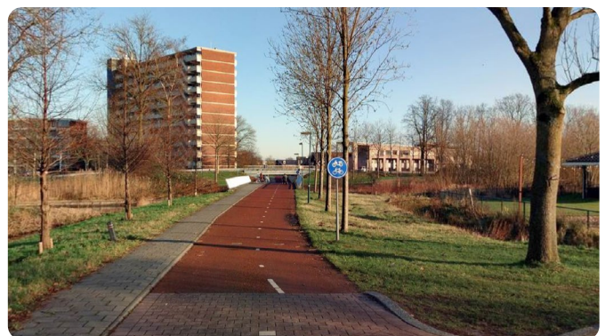
Aanzicht fietspad Groeneveldselaan vanaf de Grebbeweg, 2018 ©2021 Cyclomedia
