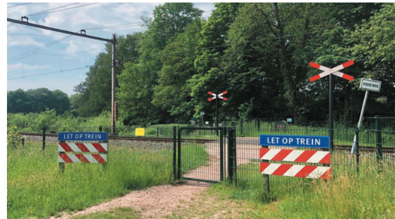
Afbeelding 1: de NABO-noord is door ProRail beveiligd met Andreaskruisen, waarschuwingsborden en een door de wandelaar zelf te openen klaphek. Het betreft hier een enkel spoor.
